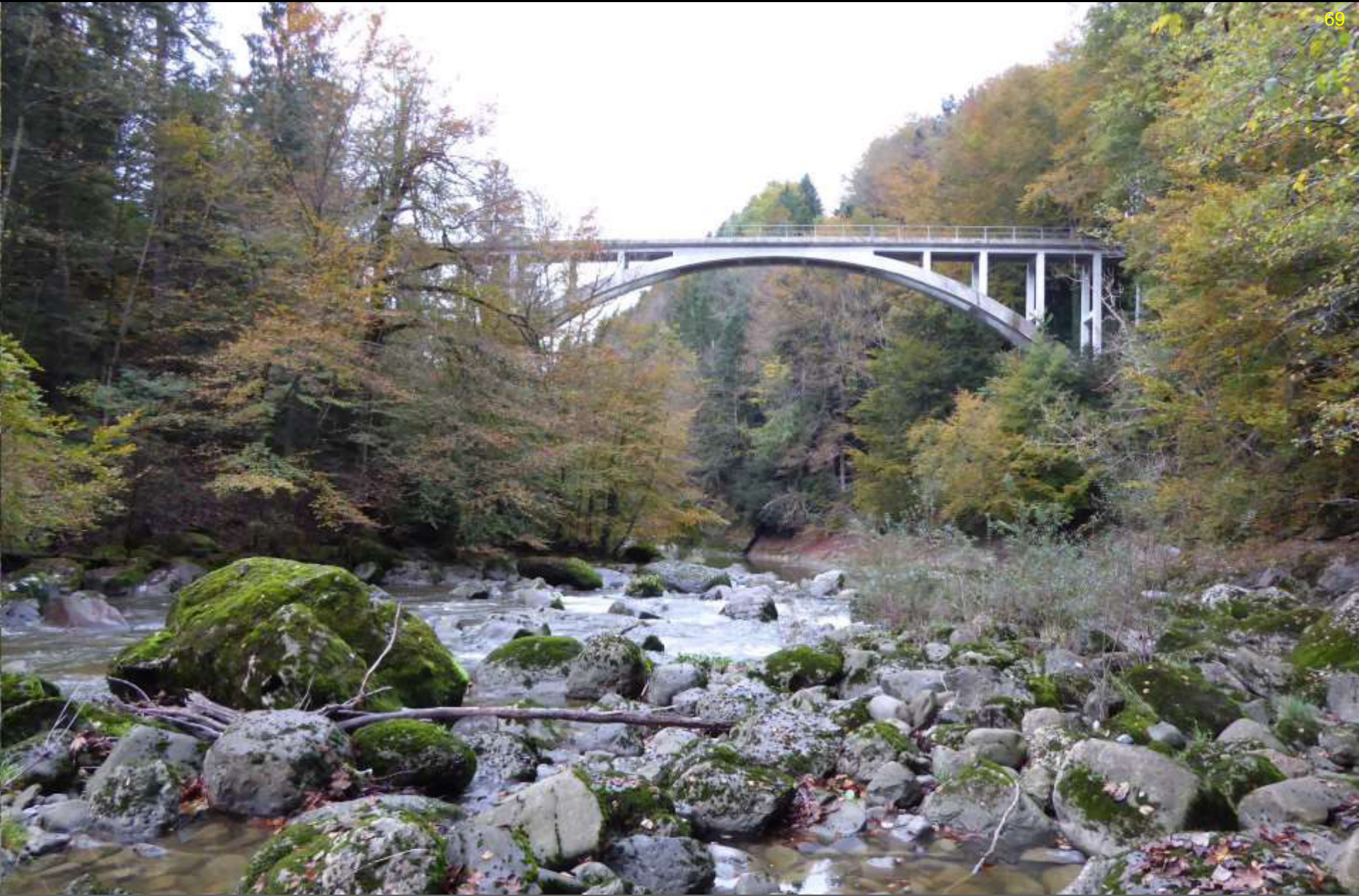
Die elegante, 1915 erbaute und 1998 sanierte Scherenbrugg über die Sihl, eine der ältesten Betonbrücken der Schweiz! 07.10.2014
