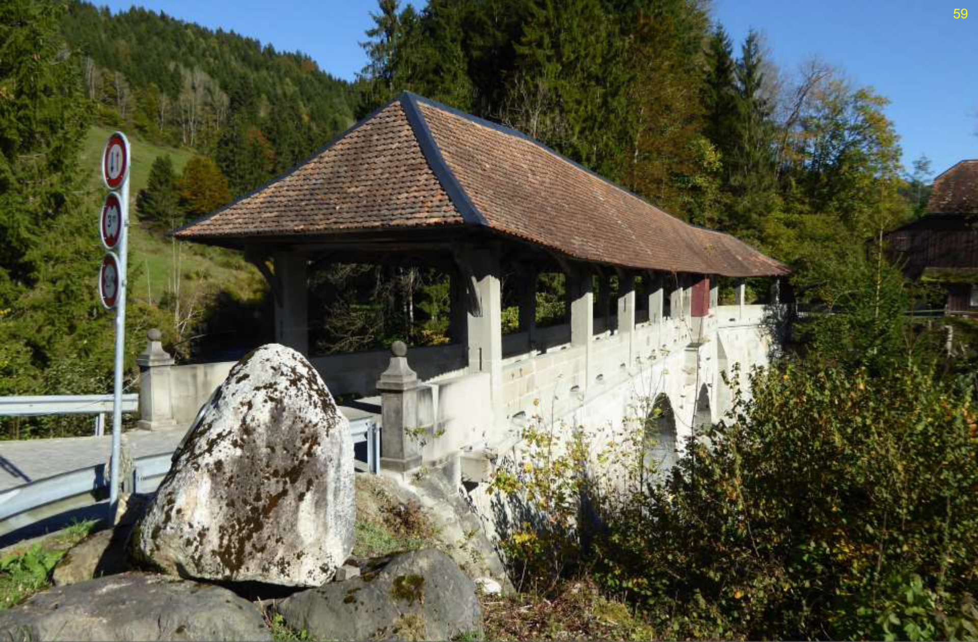
Die Tüfelsbrugg (Egg), 17. Jh, mit Biberschwanzziegeln gedecktes Walmdach mit gedeckt, vom linken Sihlufer aus, 09.10.2014
