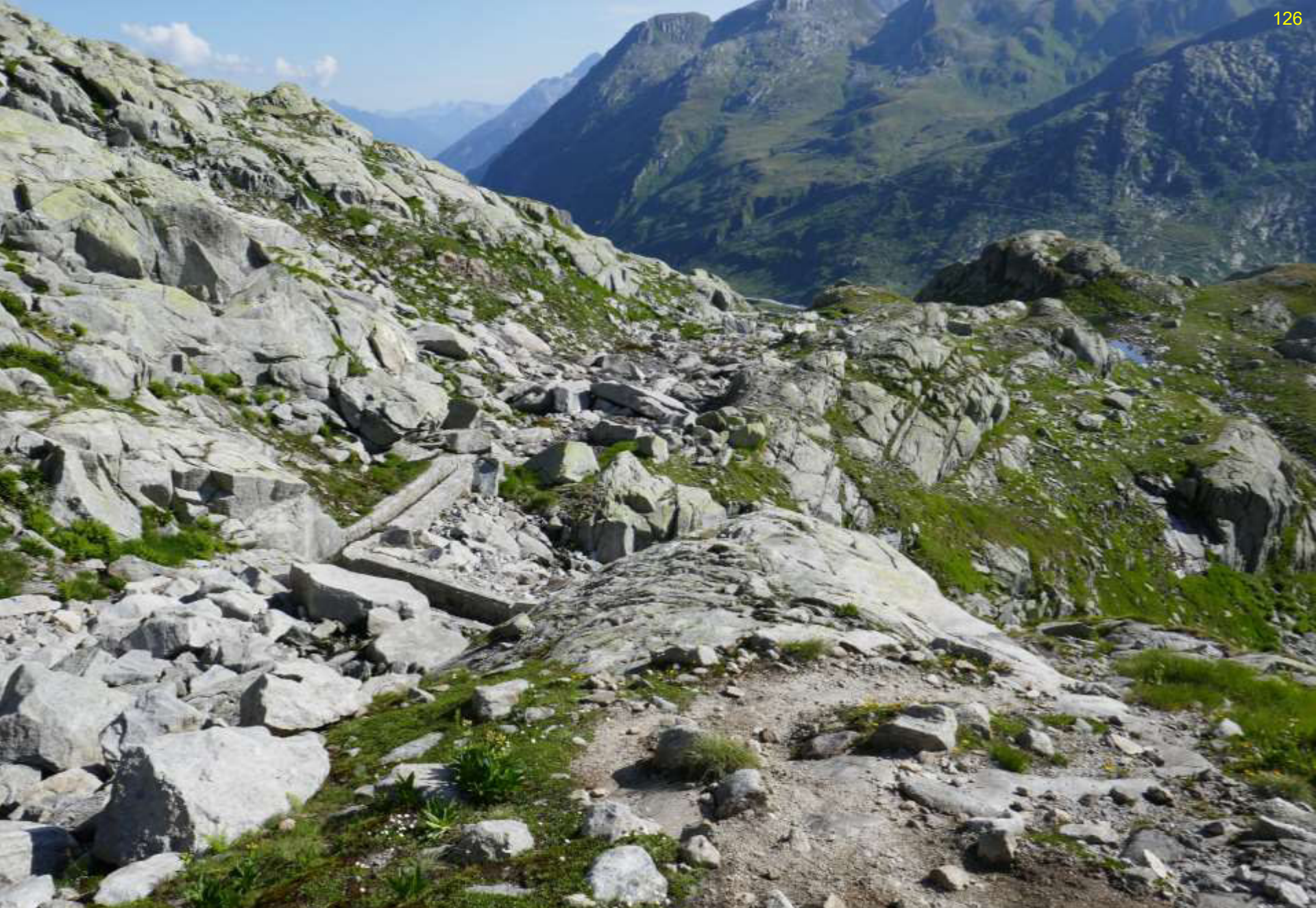
Die Mauer mit der der Bach abgeleitet wird, 30.07.2018
