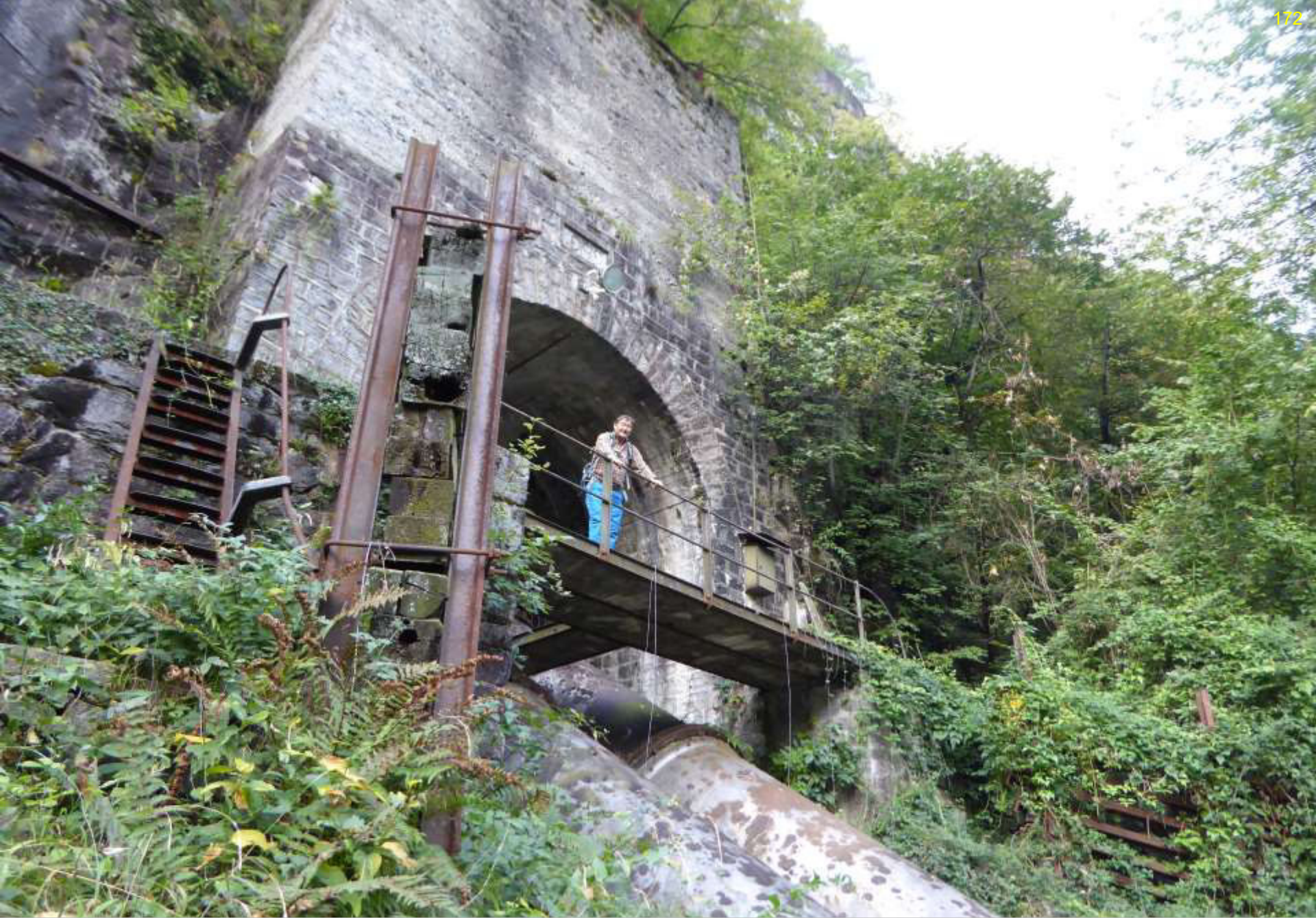
Die Überquerung der Druckleitung
