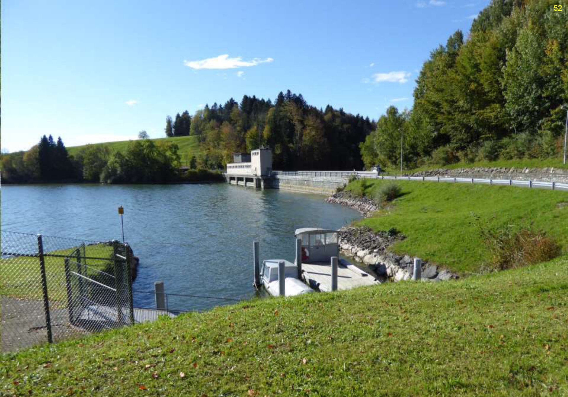
Die Staumauer des Sihlsees, 09.10.2014 (480 Höhenmeter bis zum EW)
