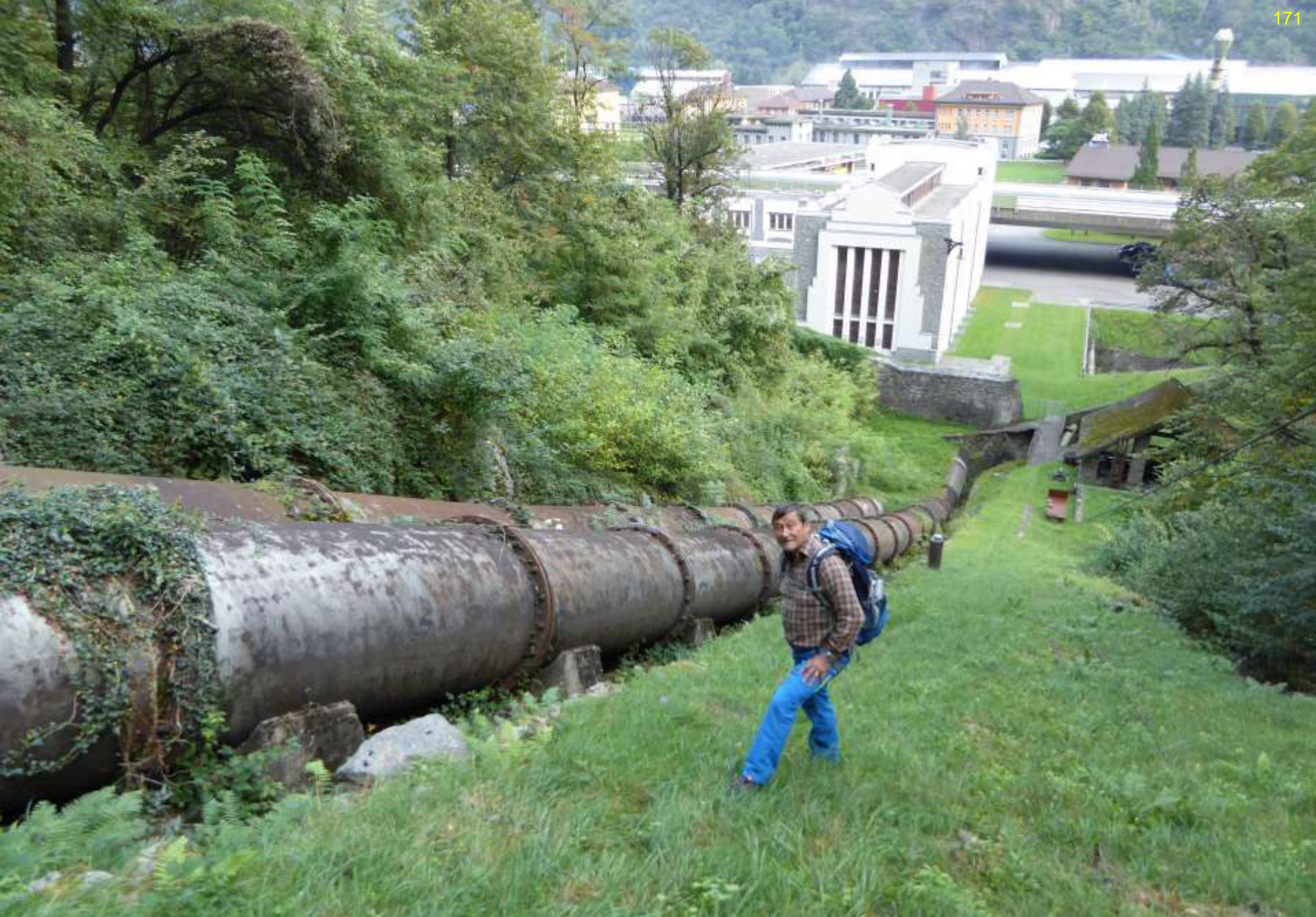
Ein Blick zurück entlang der stillgelegten Druckleitung
